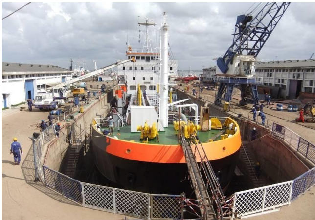
Dique seco de 110 metros
