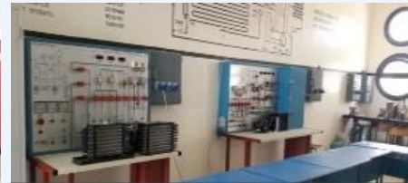
Laboratoire des installations frigorifiques
