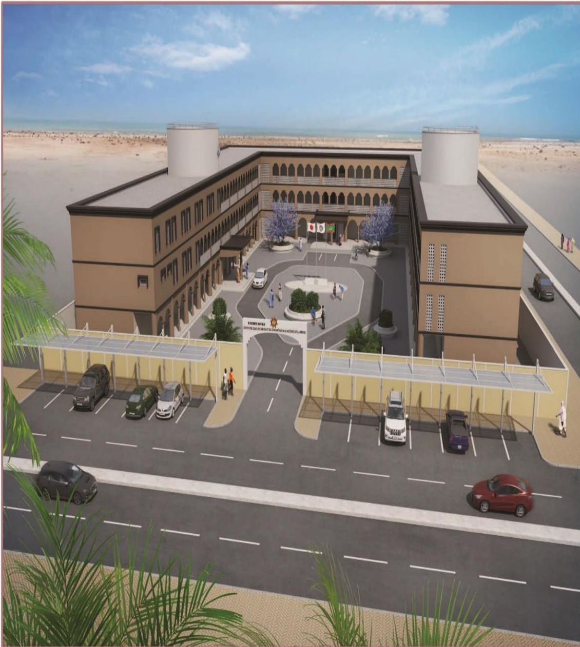
Le projet d'amélioration des installations du CQFMP
